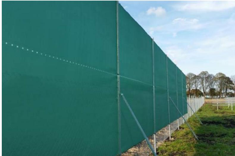
Abbildung 20: Beispiel eines Anlagenzaunes mit Sichtschutzelementen - Quelle: Accura Fachhandel
