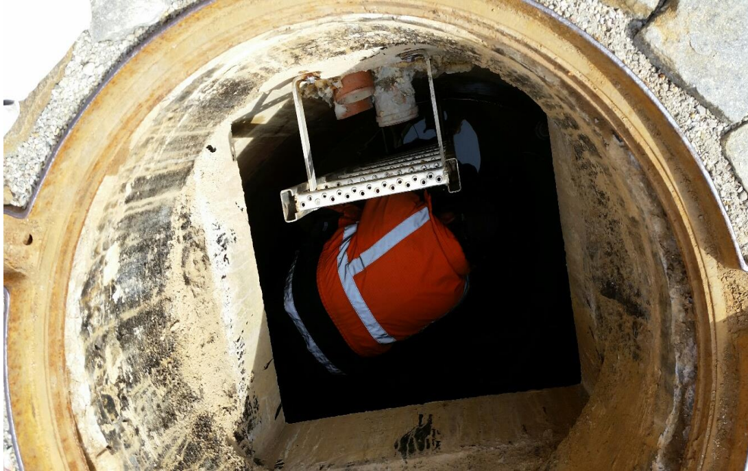
Einbau neuer Kabel und einer neuen Steuereinheit im Brunnenschacht
