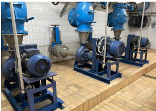
Um noch mehr Energie einzusparen, werden Abwasserpumpen und Gebläse mit hoher Laufleistung auf effizientere Energiespar-Motore umgerüstet.
