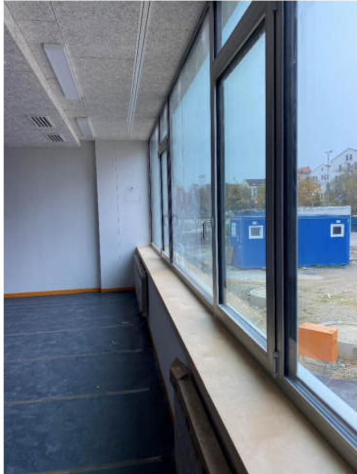
WDVS an Fassade und neue Fensterelemente
