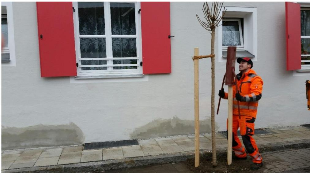
Selbstverständlich müssen die Bäume auch mit einer Verankerung versehen werden. Hier zu sehen ist das Einschlagen der Baumbefestigungspfähle mittels einer speziellen Pfahlramme.
